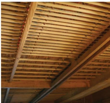
Im Inneren der Orgel: Von vorne nach hinten wird der Luftdruck zu den Registern weitergeleitet. Von links nach rechts führen Steuergestänge, die die Ventile der einzelnen Pfeifen öffnen, so dass ein Ton erklingt.
